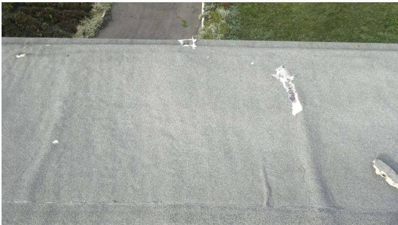
Фото 4. Протертости рулонного ковра.
