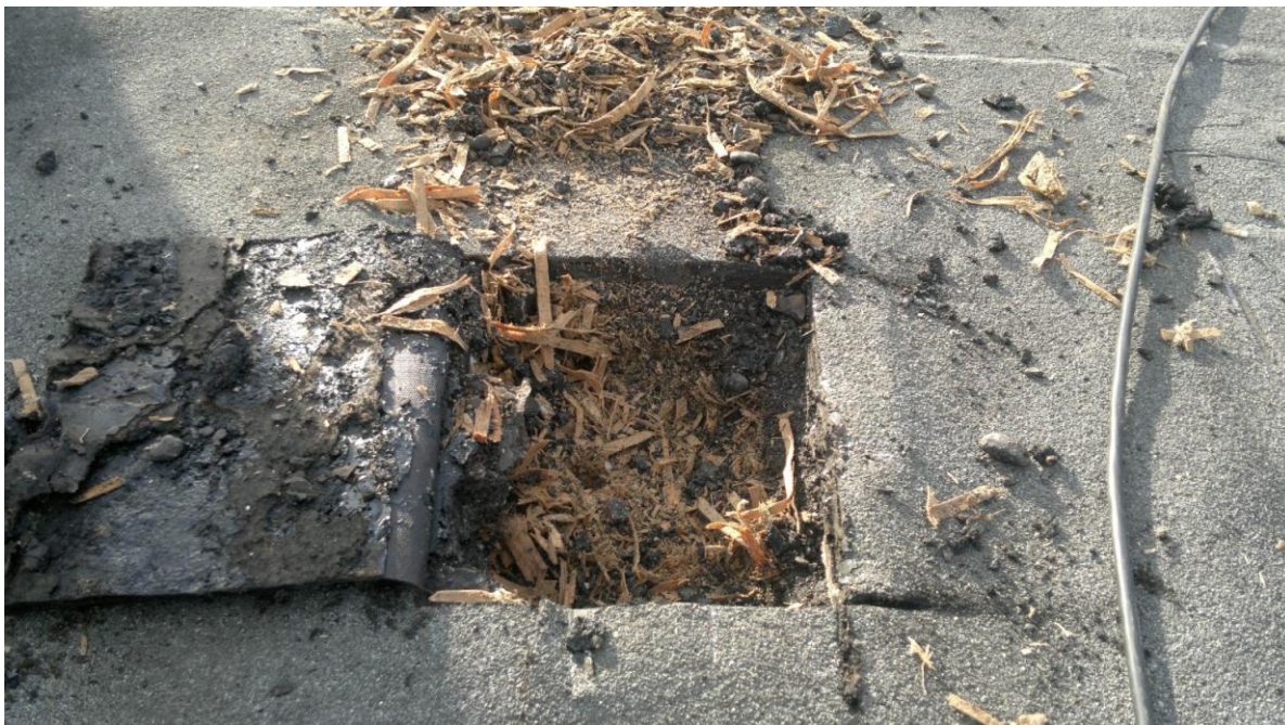
Фото 13. Вскрытие кровли здания.
