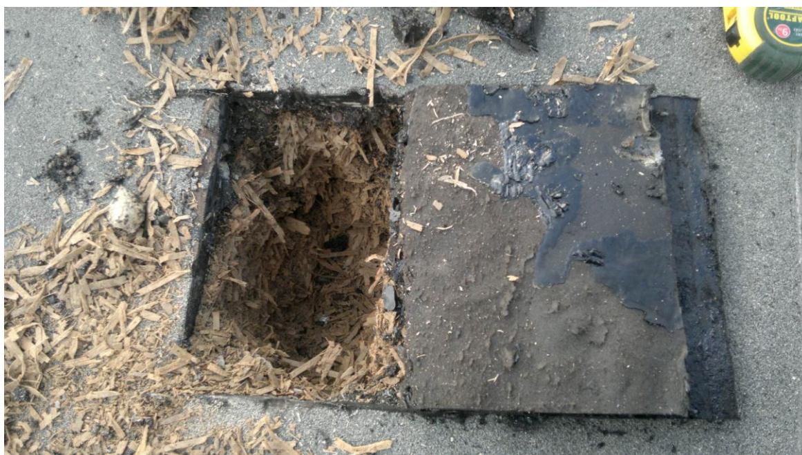
Фото 14. Вскрытие кровли здания.
