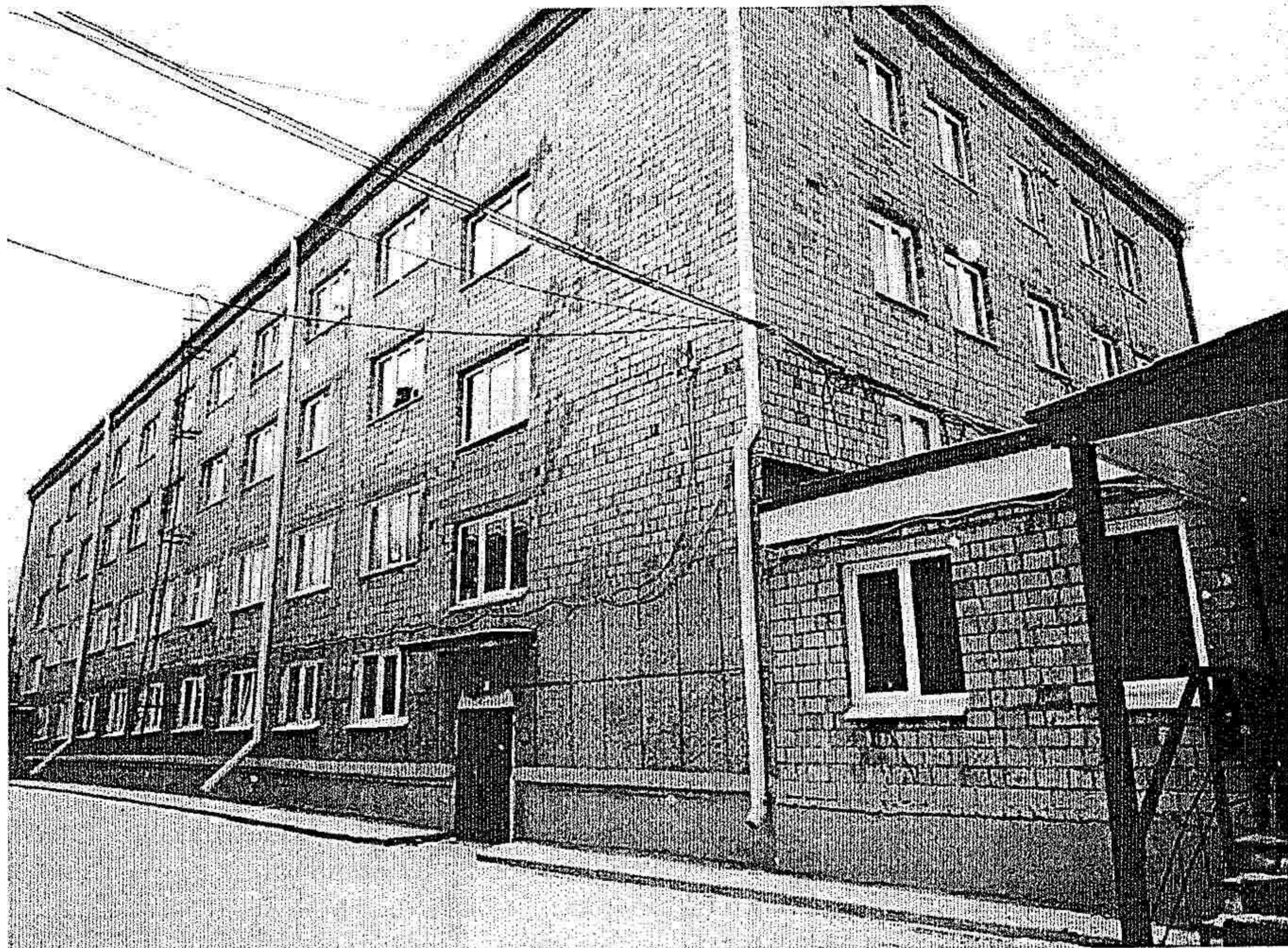
Рис.1. Общий вид здания.
