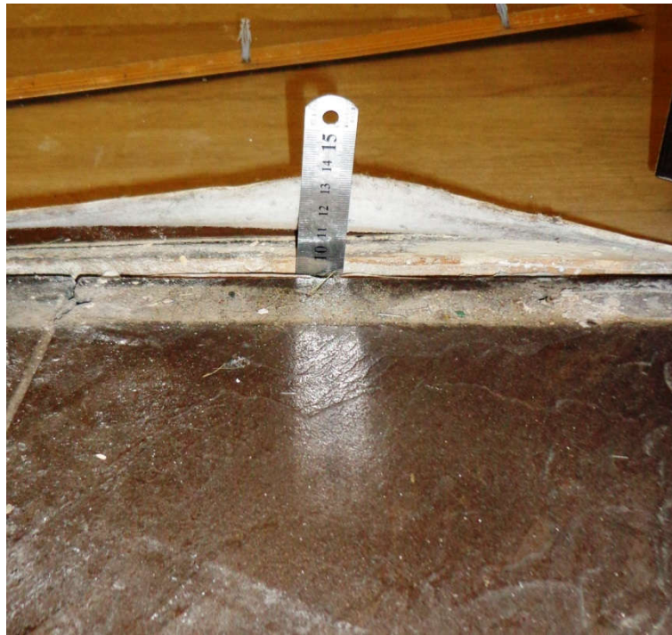
№230-232 коридор/комната толщина стяжки с керамогранитом 90 мм
